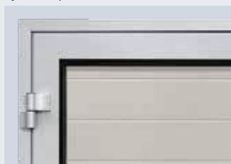
Vue de l'intérieur avec panneaux
