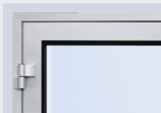
Vue de l'intérieur avec vitrage synthétique
